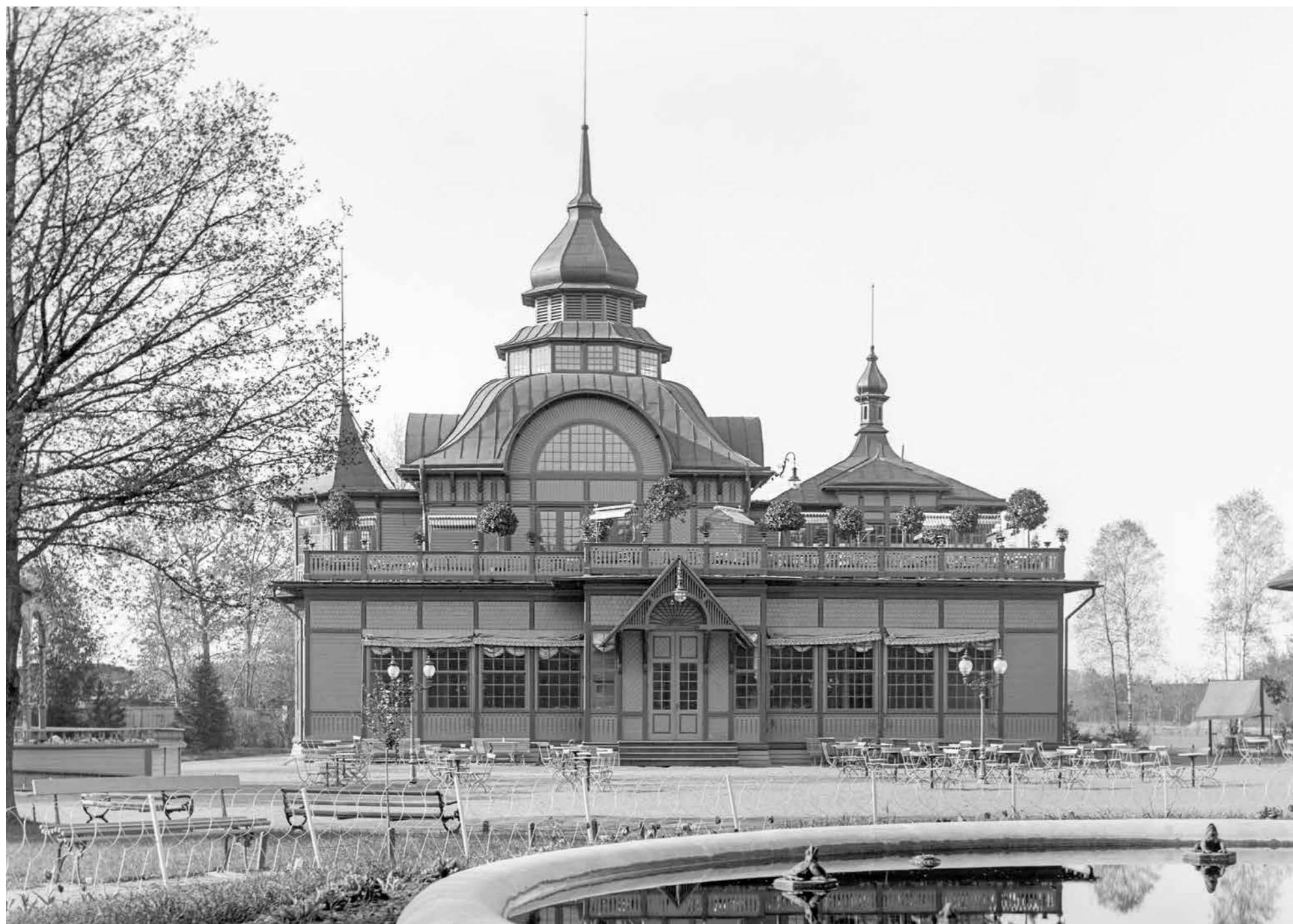
Den mycket omtyckta restaurangen i Stadsträdgården byggdes i början av 1900-talet och placerades på samma plats som det tidigare schweizeriet. Bilden tagen före ombyggnaden på 1930-talet. Restaurangen blev tyvärr lågornas rov 1959. Arkitekt: Svante Dylén. Foto: Karl Nyström, Värmlands Museum.
